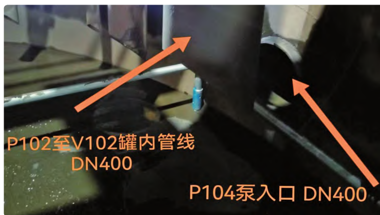
图 10 罐内管线处理情况，管口距离罐底约 3 m
