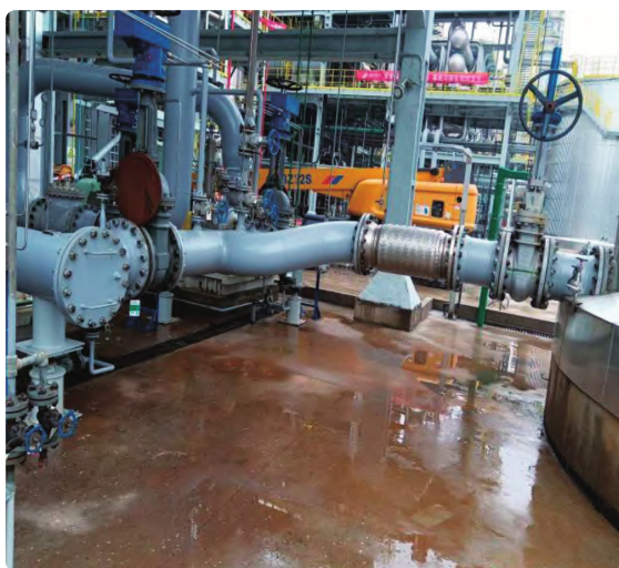
图 6 泵入口管线情况 1
