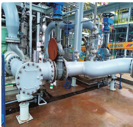
图 7 泵入口管线情况 2
