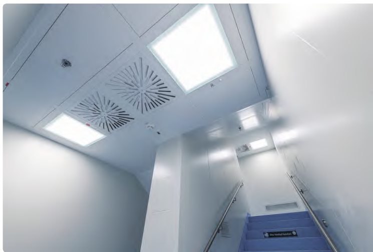
洁净室楼梯上的网格式天花板
