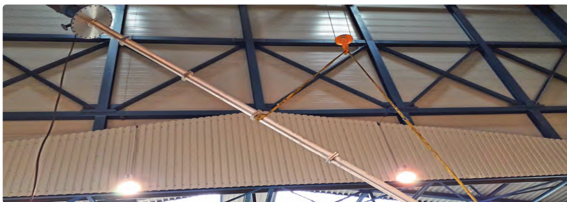
该泵的总长度为 11 m，在 Rheinhütte 的测试坑中进行了测试，以提供必要的淹没深度
