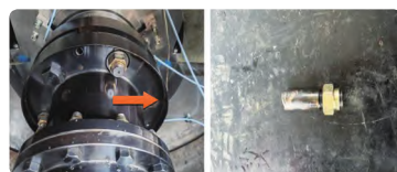
图 4 联轴器螺栓断裂及磨损情况
