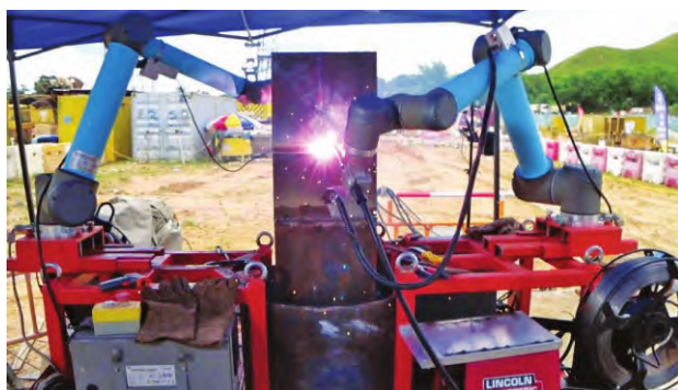
两台 SQD-Robo Welder 自适应焊接机器人同时进行工字樁焊接
