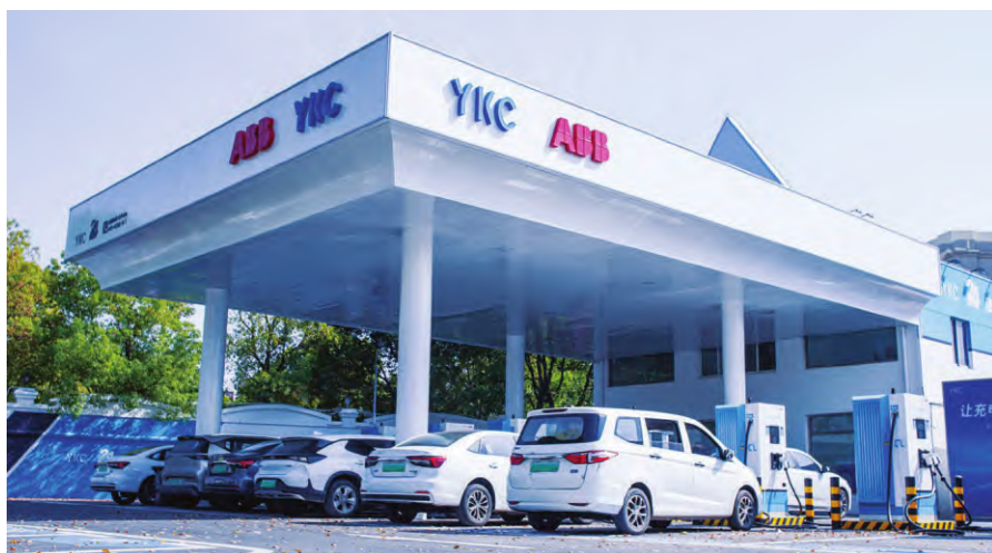
ABB 电动交通携手 YKC 云快充共建上海沪青平公路充电站
