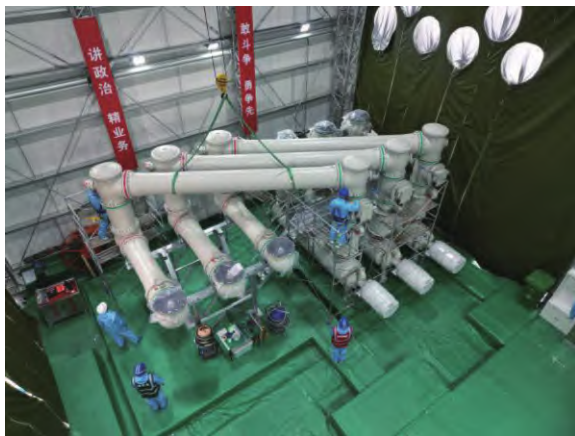
图1 500 kV GIS现场安装实景图
