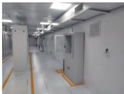
图5 吊装风冷装置现场图
