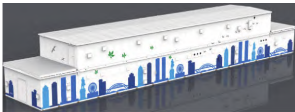
图3 上层主控室下层高压室的预制舱
