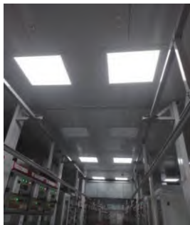
图6 照明模块及机器人轨道
