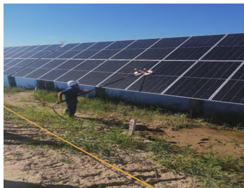
图 1 人工清洗光伏板
