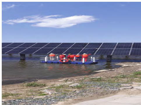
图 2 水面载具上清洗光伏板
