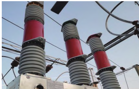
图3 现场开关更换情况
