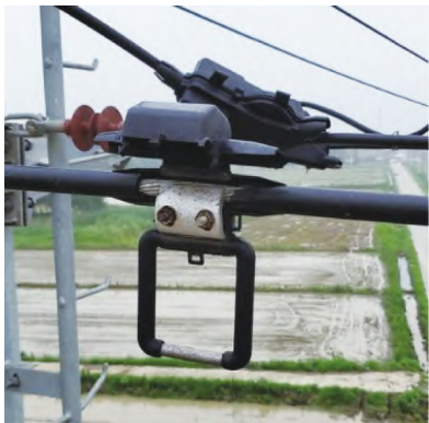
图1 接地线夹 (JDL)
