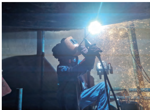
图6 碳弧气刨消除缺陷
