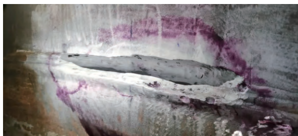
e) 焊缝检测情况
