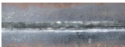
a) 打底焊缝
