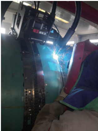
a) 外焊设备焊接
