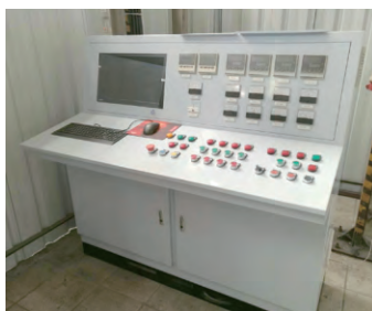
图21 真空增压铸造控制系统
