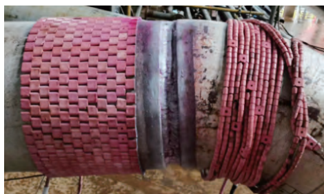
图6 第一次射线检测后做PT检测
