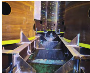
图15 吸力锚底座固定
