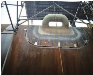
b) 吊耳组对焊接
