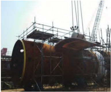
a) 吊耳吊装就位
