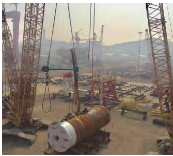
a) 吸力锚倒运
