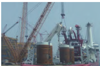
b) 吸力锚吊装装船
