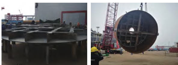
a) 正造法拼接顶盖结构散件 b) 顶部盖板翻身拼接
