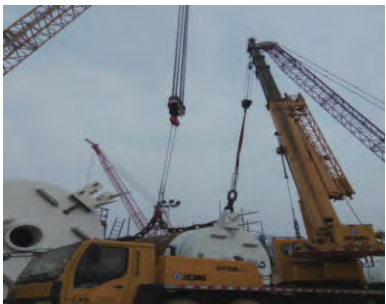
b) 多设备配合锚链就位作业
