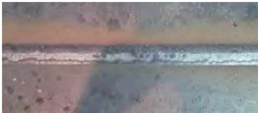
图2 焊接试板焊缝成形
