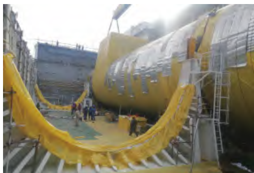
图9 罐体线型与鞍座结构线型一次匹配到位
