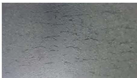
图1 厚板表面星形裂纹
