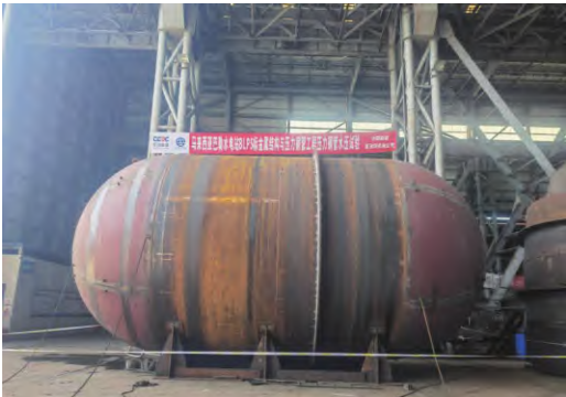
图2 巴莱水电站压力钢管水压试验现场
