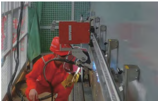
图7 桥位环焊缝机器人焊接
