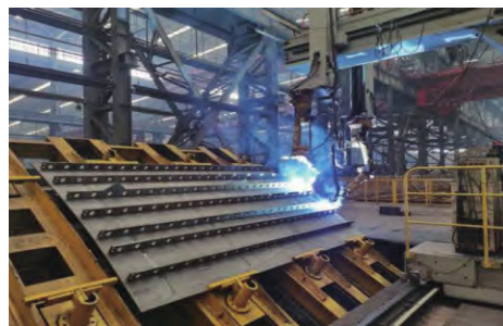
图2 壁板单元纵向加劲肋焊接
