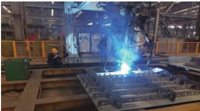
图3 壁板单元横向加劲肋焊接
