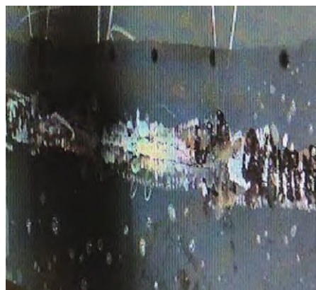
图4 压力气泡检测表面状态
