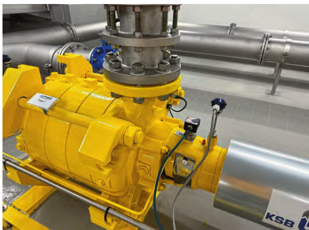
在巴伐利亚泵站，Bestsens 公司 Vibdot 多传感器节点通过采用数字监控技术，实时采集现场数据并及时提供预警
