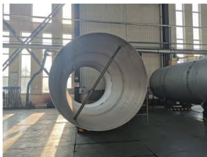
图 4 筒体内部焊接临时支撑
