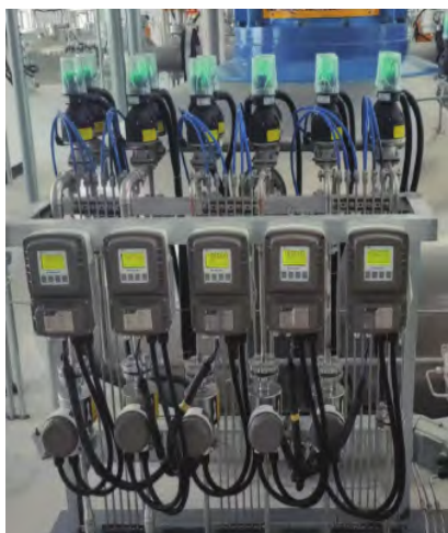
图3 目前较为先进的流量计+调节阀的补料设备
