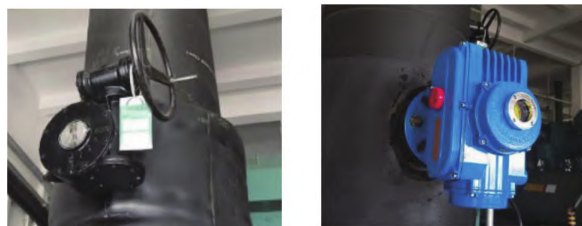
图2 手动阀与电动阀前后对照
