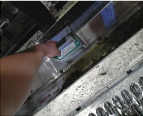
图2 底座测量水平（水平误差： \pm 0.2\text{mm} ）
