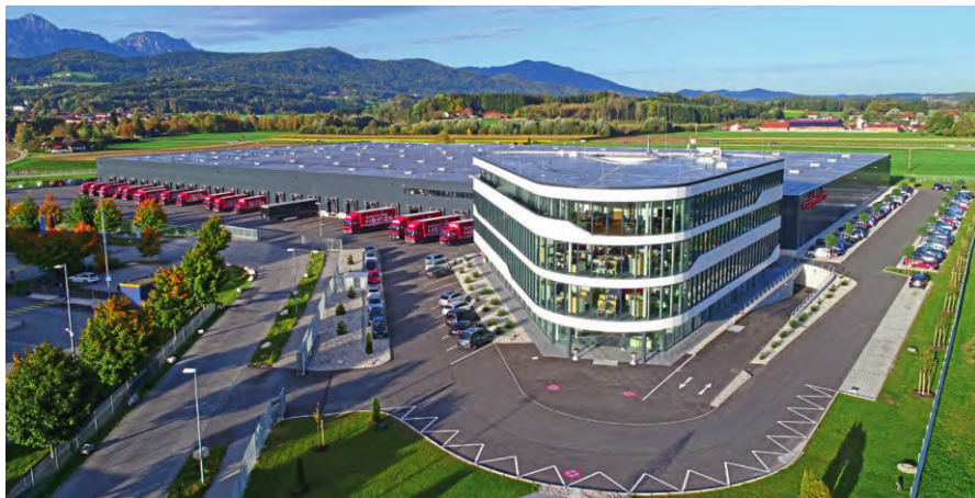
图 2 Sanitär-Heinze 公司在巴伐利亚的中央仓库。这家中型公司物流中心原来的纸质订单完全实现了数字化
