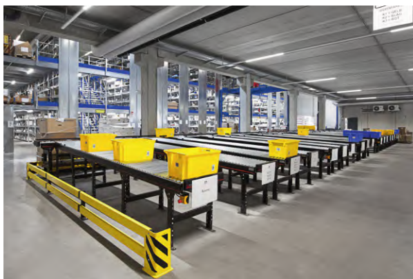
图 3 配备了自动化周转箱运输线的小件仓库
