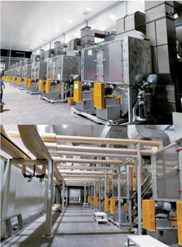
图 3 导热油管路安装前、安装后
