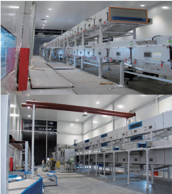
图 4 涂布机安装过程
