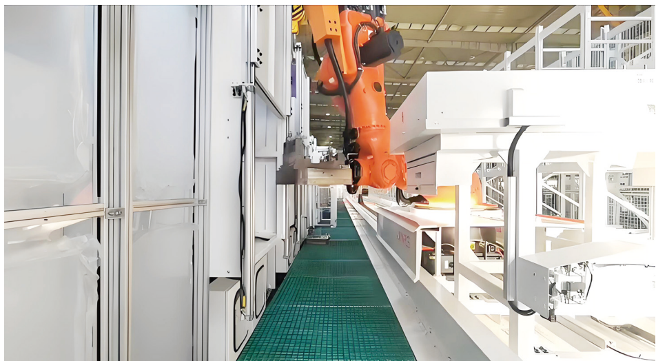
图3 现场应用照片
