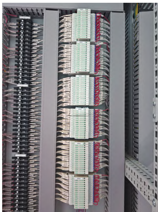
图6 现场安装场景
