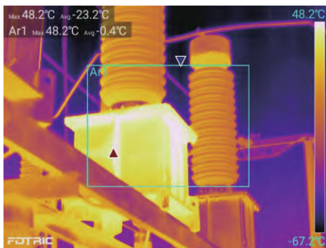
图1 4-9电压互感器红外成像
