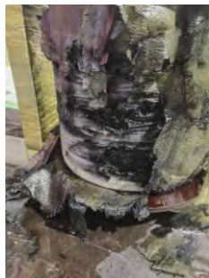
图9 中间变压器下部放电
