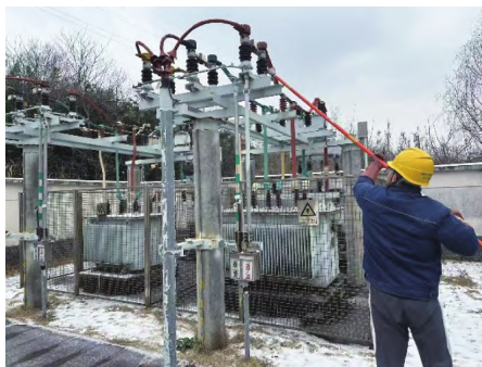
图3 运维人员清理绝缘子冰层
