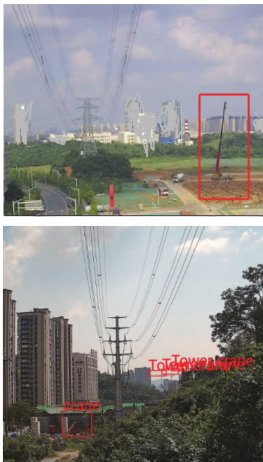
图2 可视化设备对于输电线路安全提升
