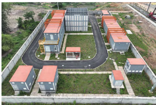
图1 龙口110 kV非金属模块化预制舱式智能变电站鸟瞰图
