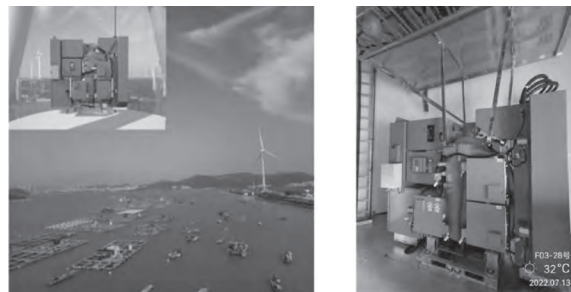
图1 应用于风电系统的72.5 kV GIS装置
