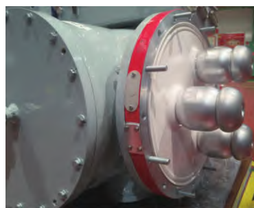
图9 145 kV GIS单间隔试验母线内部安装图
