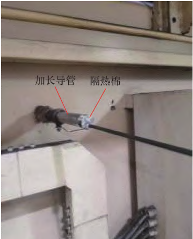
图4 延长导管实物
