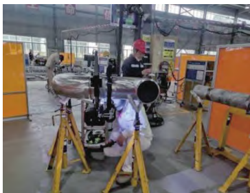
图14 预制车间焊接现场
