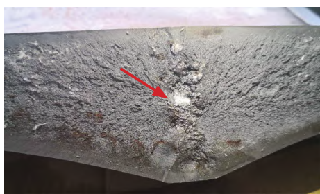
图3 断裂源位置形貌
