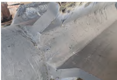
图1 电动机主轴筋板处的裂纹
