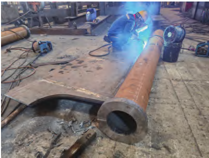
图6 锚固腹板与锚管间熔透角焊缝的焊接
