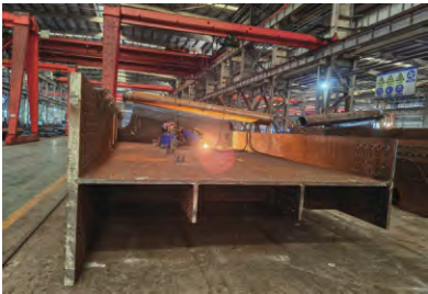
图8 锚管块体与边主梁之间的焊接
