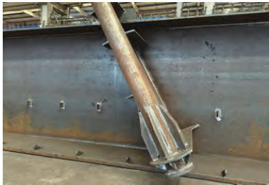
图9 边主梁节段焊接完成
