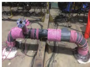
图11 现场典型热处理接头
