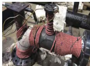
图12 现场复杂热处理接头
