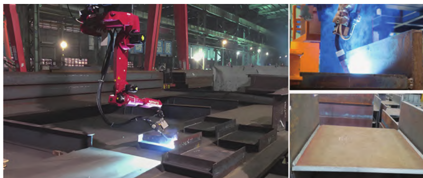
图14 钢结构机器人焊接系统用于H型钢的实际焊接效果
