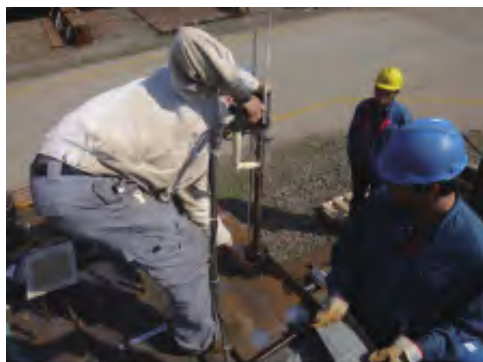
图2 传统手持式埋弧螺柱焊
