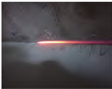
图6 焊缝背面透红
