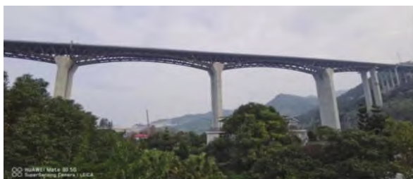
图2 福建莆田高速沙溪大桥
