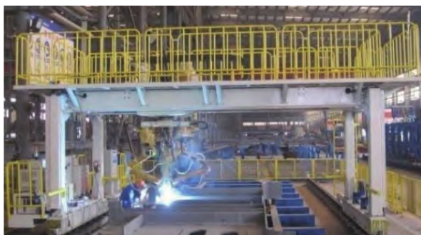
a) 横隔板加劲肋机器人焊接
