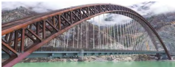
图1 西藏拉林铁路雅鲁藏布江特大桥
