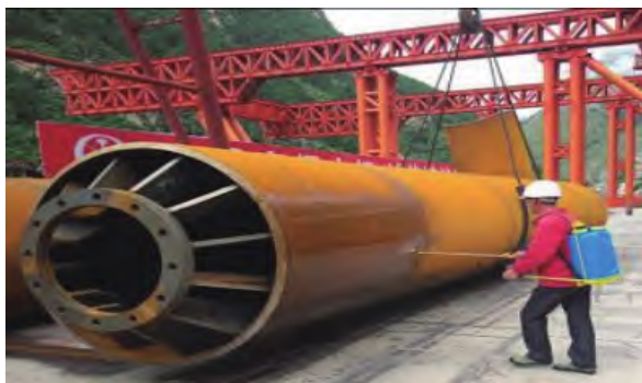
图3 耐候钢桥梁构件喷水处理
