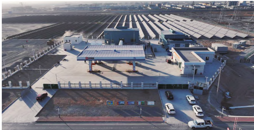
新疆首个离网光伏发电制氢加氢 EPC
