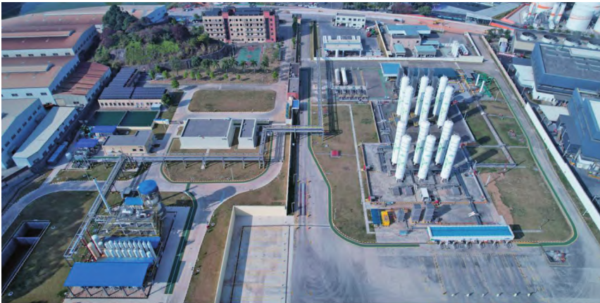
国内首个大规模沼气制氢加氢 EPC 项目
